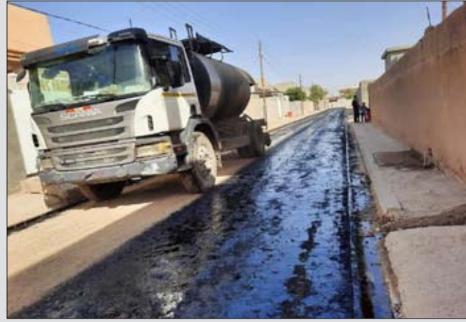
بعد الحدل وبكمية (٢٥٦٣٦٦) الخلطة الاسفلتية (استبلايزر) تجهيز المعدات وفرش طبقة من سمك (١٠سم) مع
