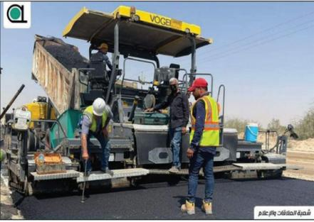
المتضررة وبمساحة ٢٨٨٠٠ متر مربع منجذ بالكامل ، وقشط المناطق المتواجدة من الطريق وبمساحة قدرها ١٥٦٥٧ متر مربع ، وبسمك ٤ سم منجذ بالكامل ، مع فرش الحصى الخابط وبسمك ٣٥ سم وبواقع طبقتين صنف B ناجح بالفحص المختبري وبكمية ١٠٨٠٠ متر مكعب منجذ بالكامل وتم إكساء طبقة الأساس القريي بسمك ١٠ سم وبمساحة ٢١٦٠٠ متر مربع منجذ بالكامل ، وتم إكساء طبقة سطحية بسمك ٥ سم وبمساحة ١٨٠٠٠ متر مربع معالجته بمادة البوليمر .
